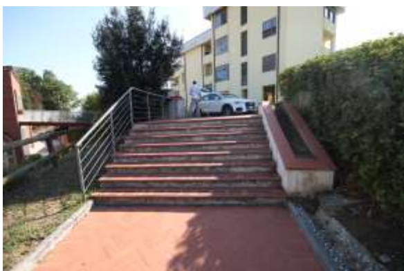
Foto n. 1 – Scala di accesso
